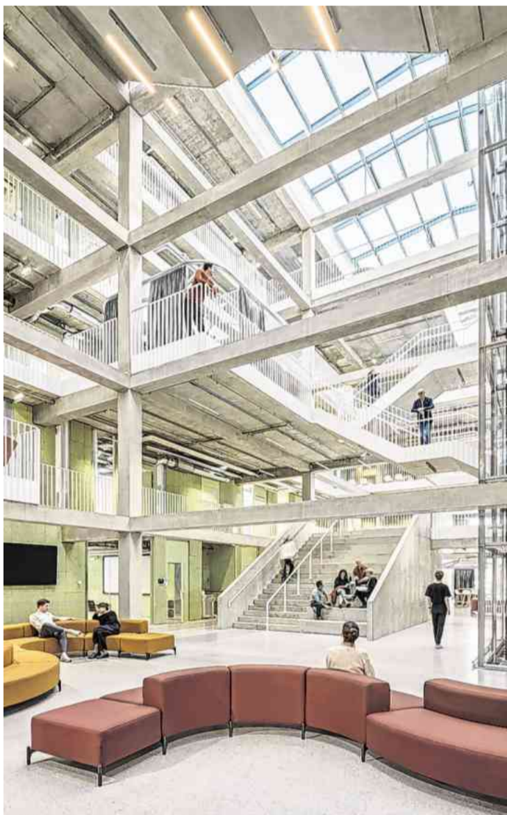
Konstruktion, Treppen, Wege: Raum in alle Richtungen
