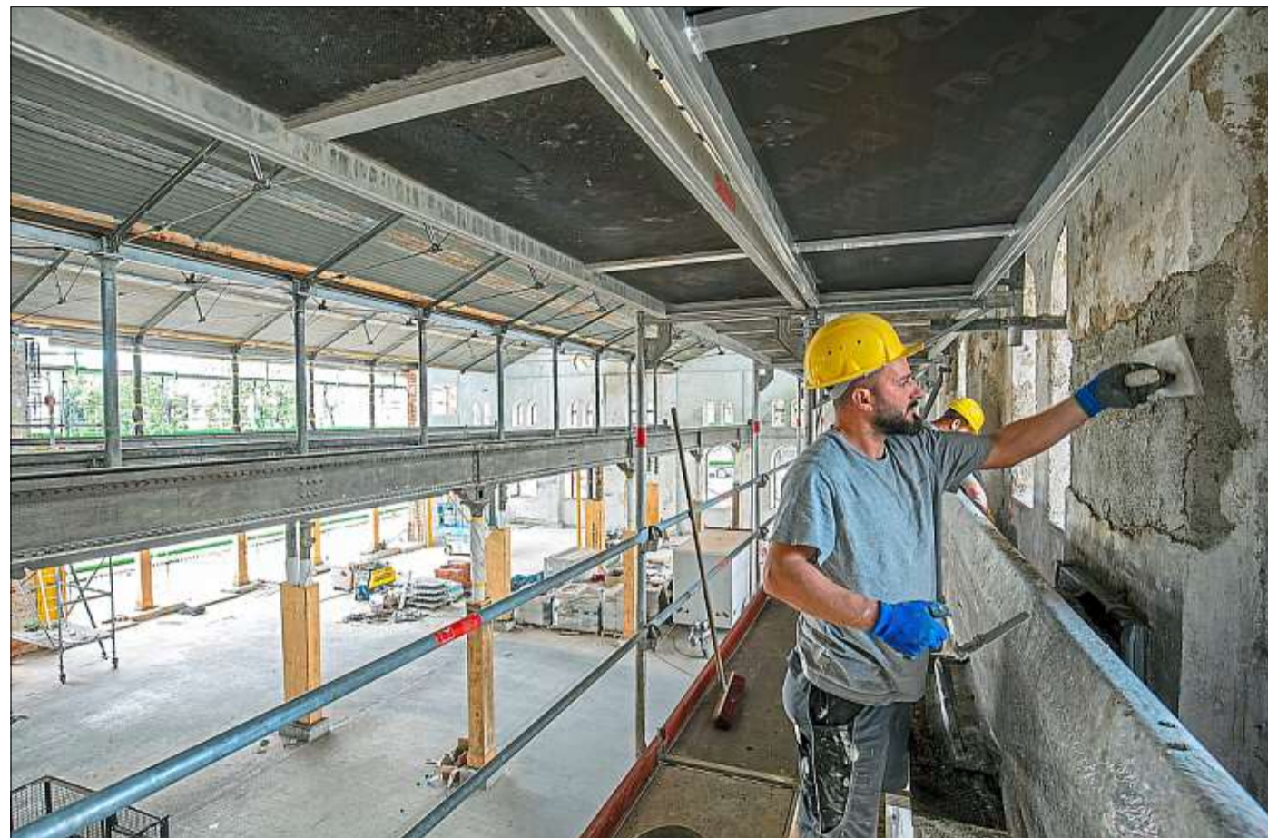
Blick auf die Baustelle des MKKD: In der Gießereihalle wird eine Innenwand verputzt.
