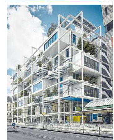
Der Neubau des City-Ikeas am Wiener Westbahnhof wurde von querkraft architekten für die Ikea Einrichtungen Handels-GmbH umgesetzt – und hebt sich von anderen Ikea-Märkten ab
