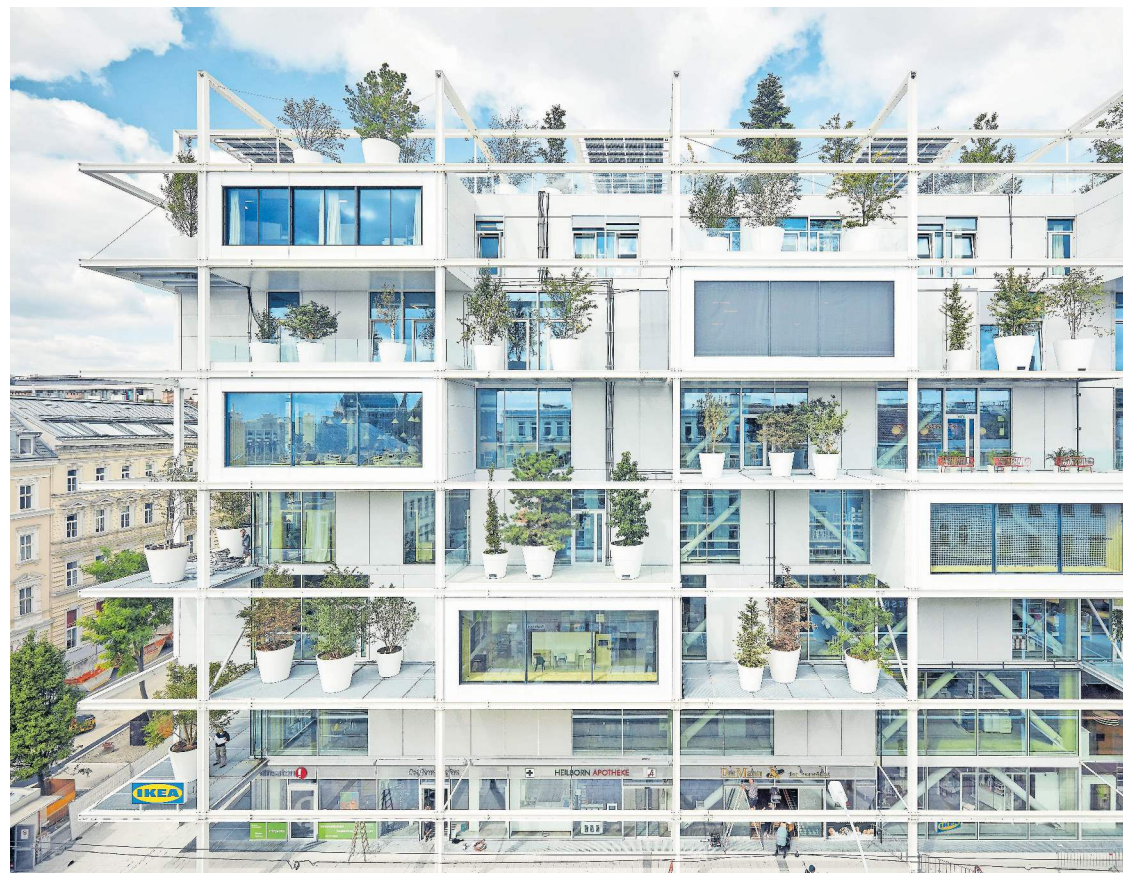
Beispiel Ikea Westbahnhof: Rasterförmige Konstruktion ermöglicht flexible Gebäudenutzung. Querkraft Architekten
