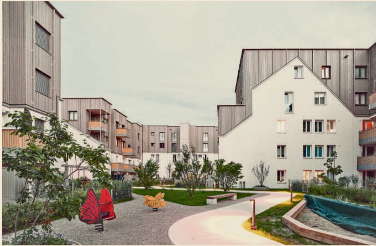
Neu und Alt, Hand in Hand: Die Aufstockung der Wohnanlage Friedrich-Inhaußer-Straße in Salzburg von CS-Architektur und Stijn Nagels.
