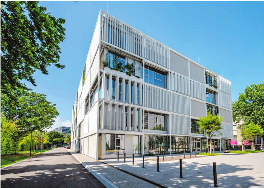
Beim „House of Schools“ der JKU wurde der Sonnenschutz in die Fassade integriert.
