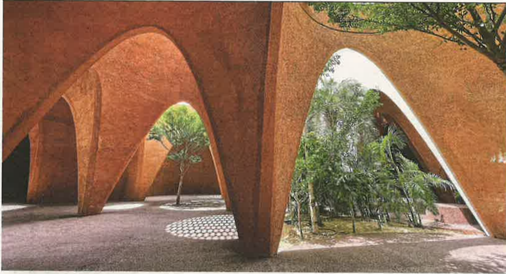
Licht, Schatten und viel Luft: die verschnittenen Kegel schaffen spannende, angenehme Innenräume
