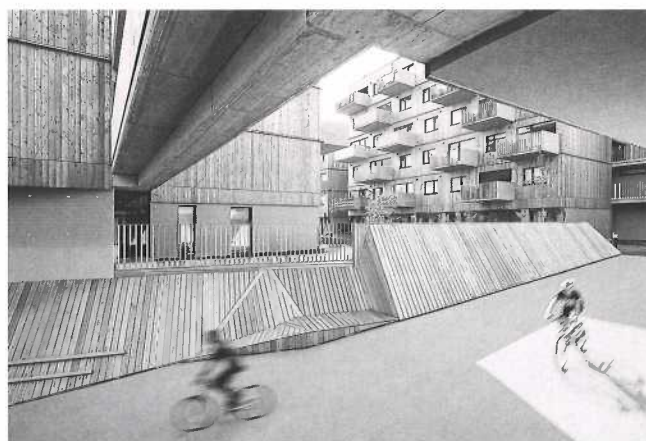
Holzwohnbau Seestadt Aspern
