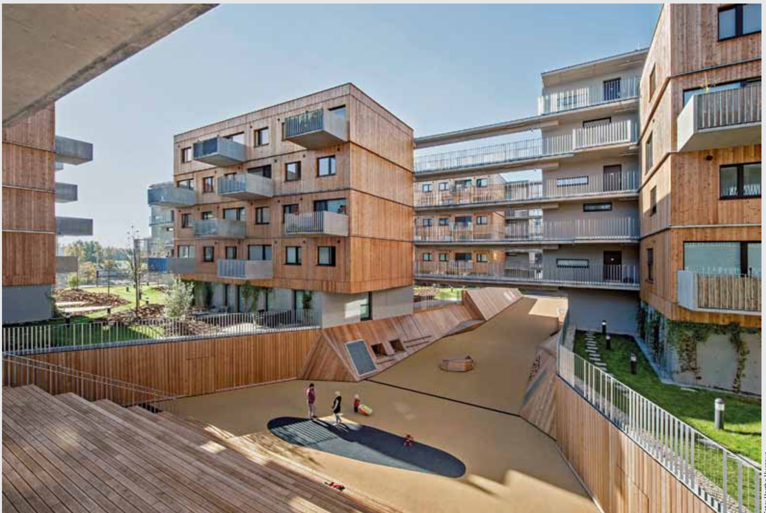
Die Gestaltung und die verwendeten Materialien lassen ein Ensemble entstehen: Die drei-, vier- bis sechsgeschossigen Wohnriegel variieren allein durch die versetzten Betonbalkone in ihrer Gestalt. Die Betonbalkone sowie die Holzfassaden sind vorgefertigte Elemente
