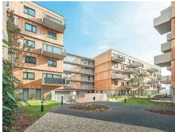
In der Seestadt Aspern steht die Wohnanlage von Querkraft, mit Holzfassade und Betonbalkonen. - FOTO: HERTHA HUMAUS/QUERKRAFT
