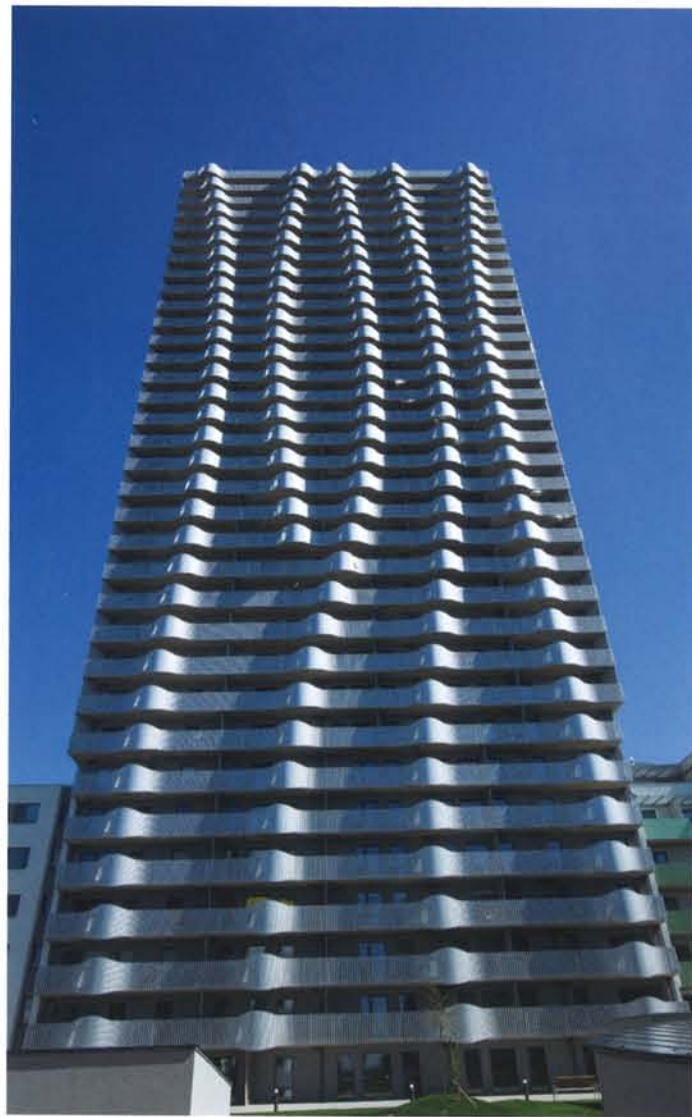
Citygate Tower: Die Außenhülle des Gebäudes prägt eine umlaufende Balkonzone, die sich vor jeder Wohnung erweitert und etagenweise ändert Architektur: querkraft architekten, Wien; Abb.: querkraft architekten – lukas dostal
