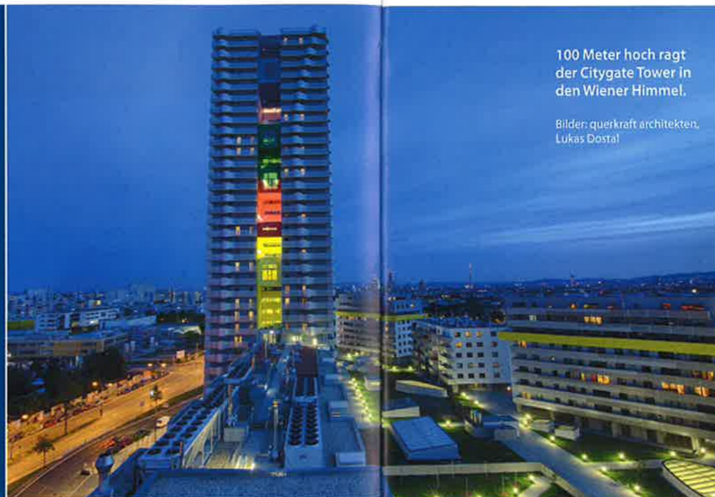
Die Fassade des Citygate Towers in Wien scheint zu fließen, eine wellenförmige, mäandernde Bewegung zu machen.
