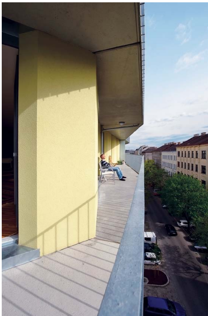
Jeder Wohnraum bietet Zugang zu der umlaufenden Balkonzone, die bis zu 27 Quadratmeter grosse Veranden ausbildet.
