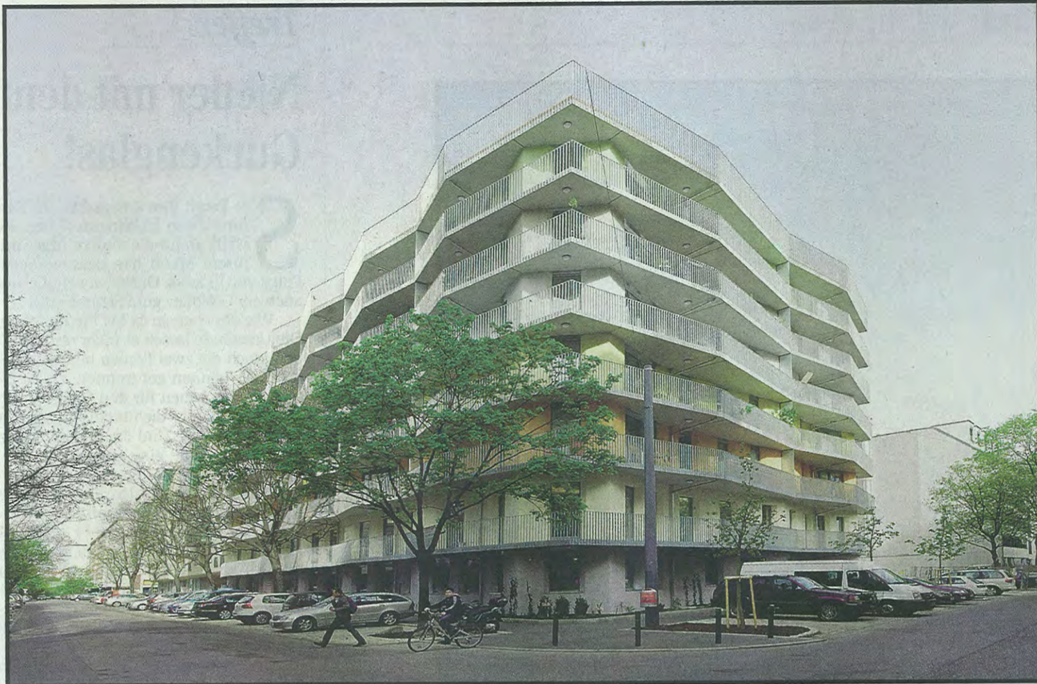
Städtebaulicher Mehrwert: Passivhaus Ecke Universumstraße/Kampstraße, Wien-Brigittenau ...
