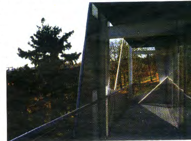
Die Aluminiumfassade wurde um Innenraum und Balkone herum gebaut. Die stützenfreie Glasfront sorgt für Genuss des Panoramas.
