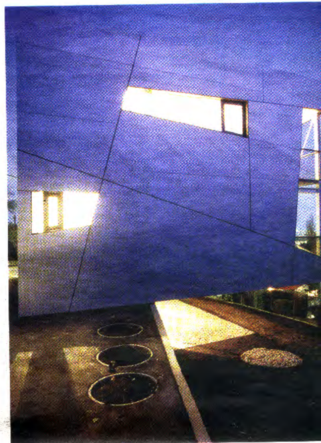
Das neun Meter tiefe Haus ist auf nur drei Metern auf einem Sockelbauwerk verankert, das aus dem Gelände herausgearbeitet wurde.
